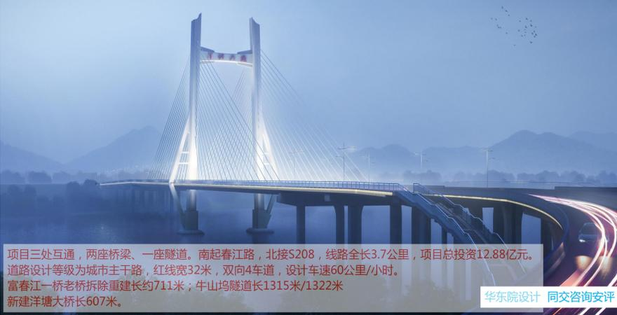
项目三处互通，两座桥梁、一座隧道。南起春江路，北接S208，线路全长3.7公里，项目总投资12.88亿元。道路设计等级为城市主干路，红线宽32米，双向4车道，设计车速60公里/小时。富春江一桥老桥拆除重建长约711米；牛山坞隧道长1315米/1322米。新建洋塘大桥长607米。
